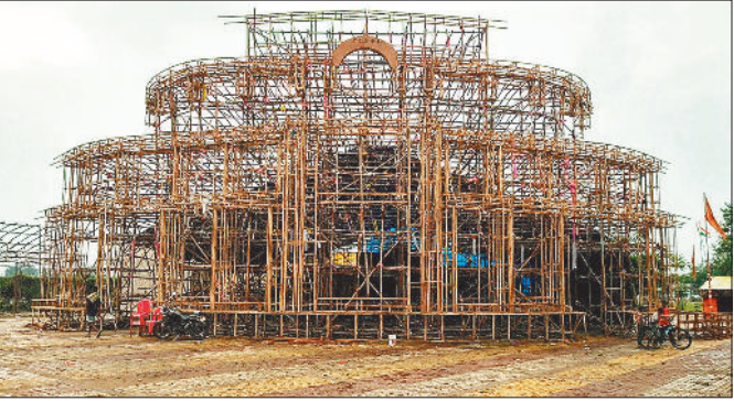
चल रहा पंडाल निर्माण का काम।
